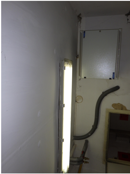
ROZVODNICE INTERNETU PODA, M.Č.014 - DEMONTÁŽ, OSAZENÍ NIŽE O MIN. 300 MM
